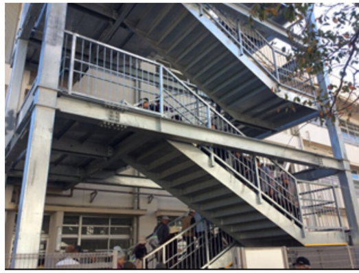
津波避難ビルにはスロープのないものが圧倒的に多い
