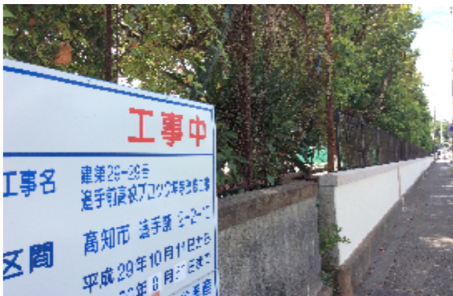
県立高校の対象校は現在すべてで改修工事が進められている
