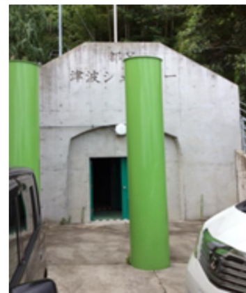
都呂地区の津波避難シェルター
